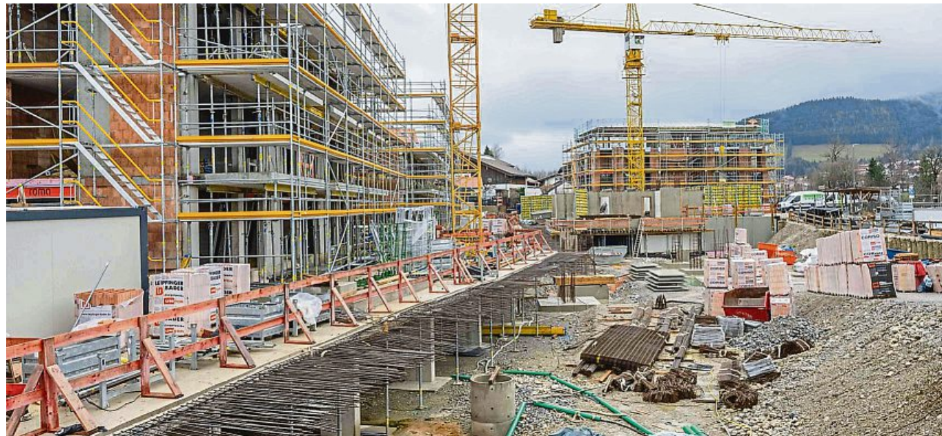
Machen wieder Fortschritte: Die Arbeiten an den Mehrfamilienhäusern, die seit rund einem Jahr auf dem Areal des alten Rathauses in Hausham entstehen.
